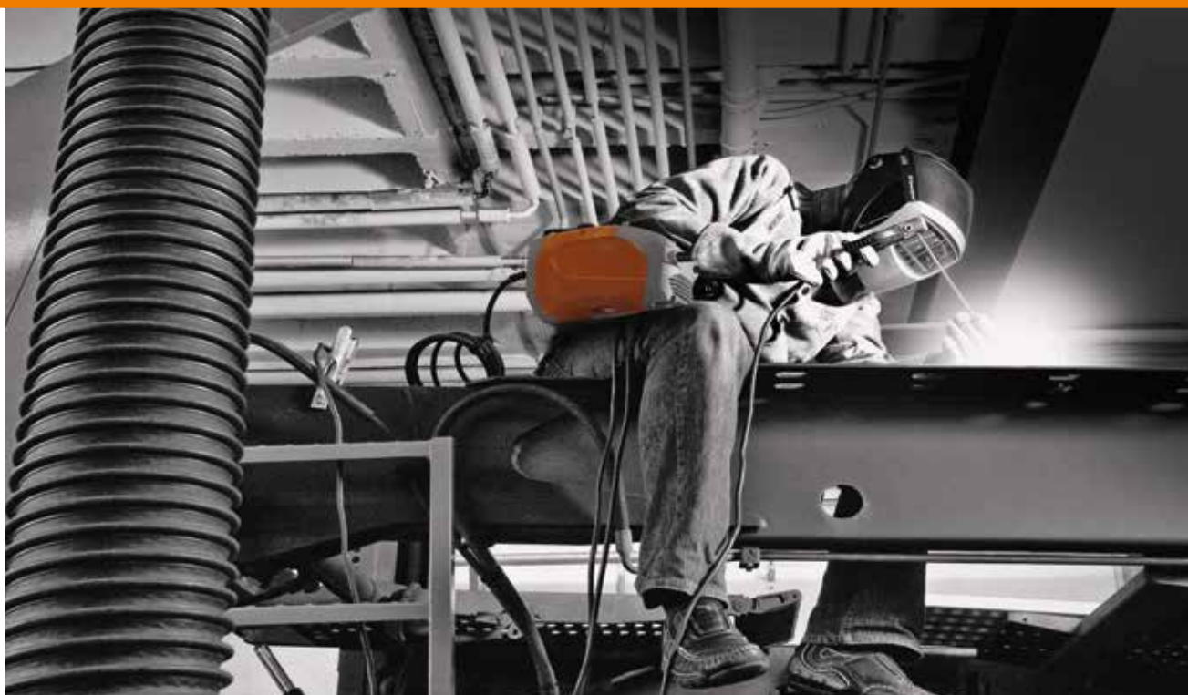
BOOSTER2 בשימוש בבניית פלדה. ניידות גבוהה, שימוש בטוח וביצועים מלאים.
